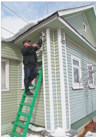
Понарино: установка нового оборудования в доме. Фото: пресс-служба ГЖИ Московской области
